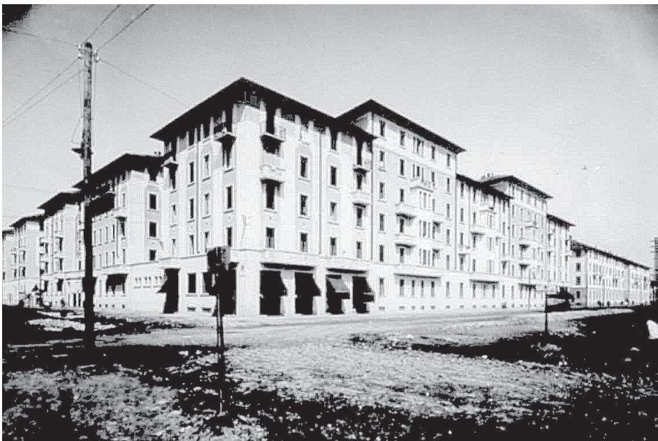
Il quartiere Baia del Re - Stadera negli anni 30 del secolo scorso
