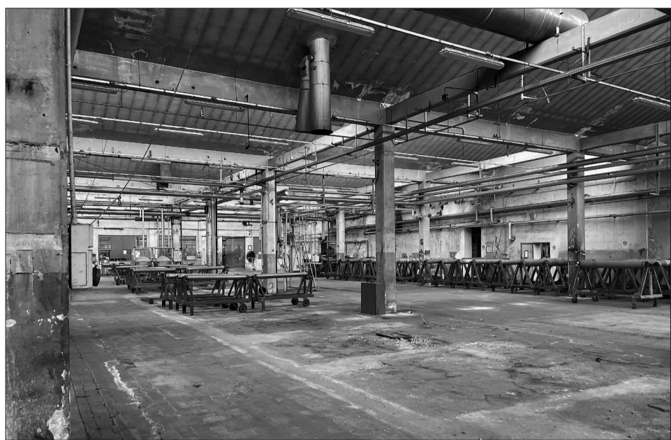
Ph. Matteo Marucco - Il Cottonificio Cederna, ormai smobilizzato dal febbraio del 2020
