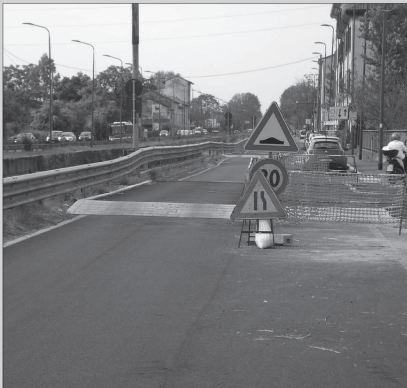
Ph. Guglielmo Landi - I dossi in costruzione sull'Alzaia Naviglio Pavese in corrispondenza del Nodo idraulico della Conca Fallata
